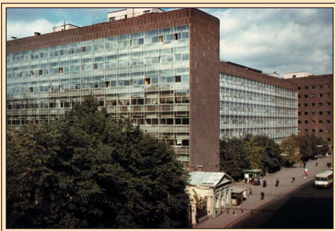
Здание ЦСУ СССР. 1969 г.
