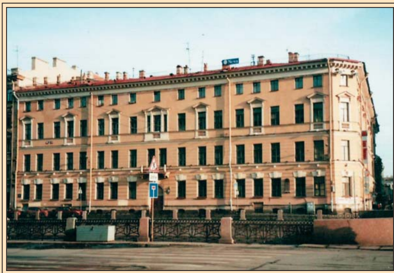
Здание, где в 1810–1830-х гг. располагалось МВД. (Наб. р. Мойки, 66).
