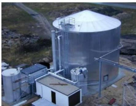
Рис.13. Анаэробные очистные сооружения для химической промышленности
