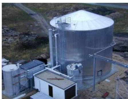
Рис.13. Анаэробные очистные сооружения для химической промышленности
