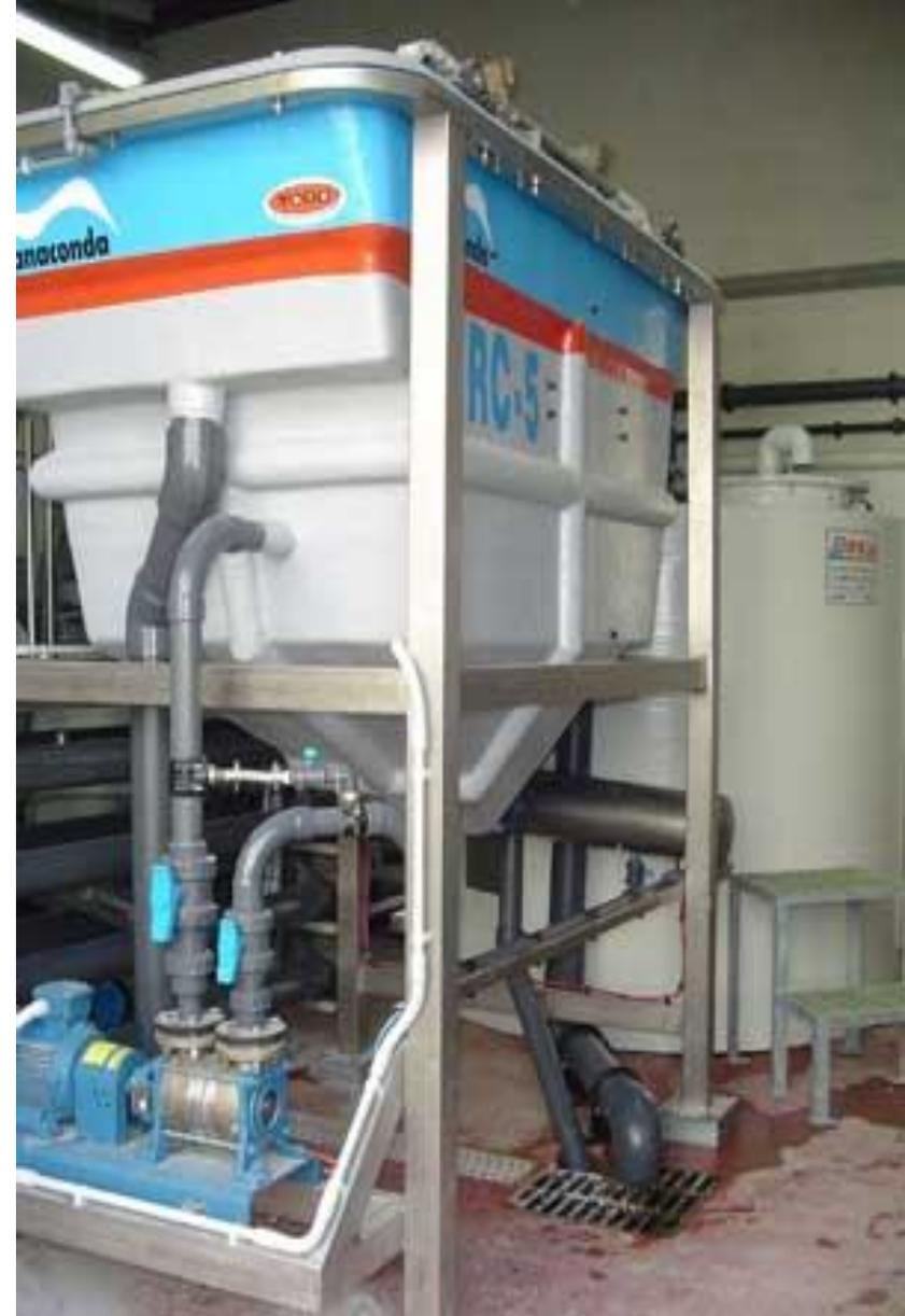
•Флотационное оборудование очистки промышленных сточных вод
