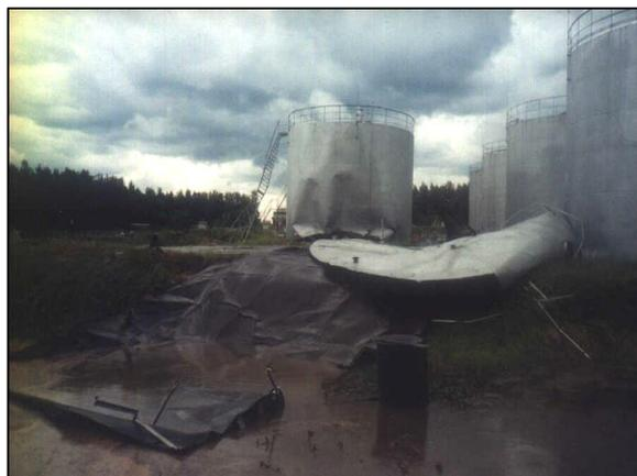
Положение стенок и крыши РВС № 8 после разрушения
