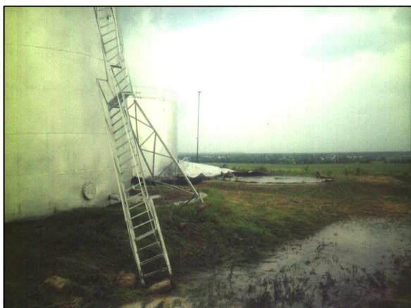
Повреждение волной прорыва и стенками аварийного резервуара соседних РВС № 6 и 7
